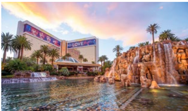
The Mirage Hotel & Casino (LASD0151)
